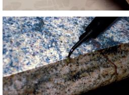
Schadstelle an der Kante mit transparentem Band abkleben. Danach AKELUX Filler transparent liquid oder AKELUX Filler transparent gel crystal zur Erstfüllung applizieren. Mit AKELUX Sichtfolie/Oberflächenstrukturstempel\*\* bedecken und 60 s/cm<sup>2</sup> mit AKELUX LED-Lichtstrahler\* aushärten.
