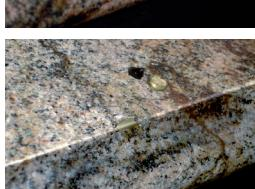
AKELUX Filler transparent liquid mit verschiedenen farbigen AKELUX Fillern mischen (max. 50% Farbanteil) und an die Objektfarbe anpassen. Ggf. mit AKELUX Structure füllen.
