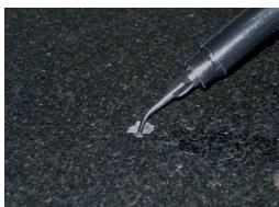
AKELUX Primer zur Haftvermittlung auftragen und diesen ca. 60 Sekunden trocknen lassen.
