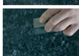
AKELUX Silikon-Schleiflein auf den AKELUX Schleif- und Polierblock legen und die Schadstelle in der Reihenfolge 2400-3200-4000 nass feinschleifen. Bei Verwendung eines Oberflächenstrukturstempels\*\* entfällt dieser Schritt.
