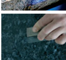
Überschüssiges Material mit AKELUX Hobel vorsichtig abnehmen. Für Kalkstein empfehlen wir den Gebrauch von Sepiaschalen. Bei Verwendung eines Oberflächenstrukturstempels\*\* entfällt dieser Schritt.
