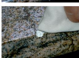
Nettoyer soigneusement l'endroit endommagé avec AKELUX Nettoyant.
