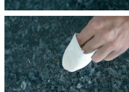
AKELUX Polierpaste auf die Reparaturstelle auftragen. Manuell mit AKELUX Poliertuch und der Filzseite des AKELUX Schleif- und Polierblocks oder maschinell aufpolieren (z.B. Dremel mit Filzscheibe).
