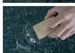
Überschüssiges Material mit AKELUX Hobel vorsichtig abnehmen. Für Kalkstein empfehlen wir den Gebrauch von Sepiaschalen. Bei Verwendung eines Oberflächenstrukturstempels\*\* entfällt dieser Schritt.
