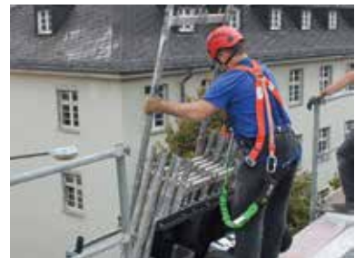
Leichtes und sicheres Entladen des Gerüstmaterials
