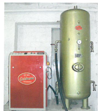
Niedrig drehender Schrauben-Kompressor in robuster Ausführung, verschiedene Leistungsstufen mit stehendem verzinktem Kessel.
