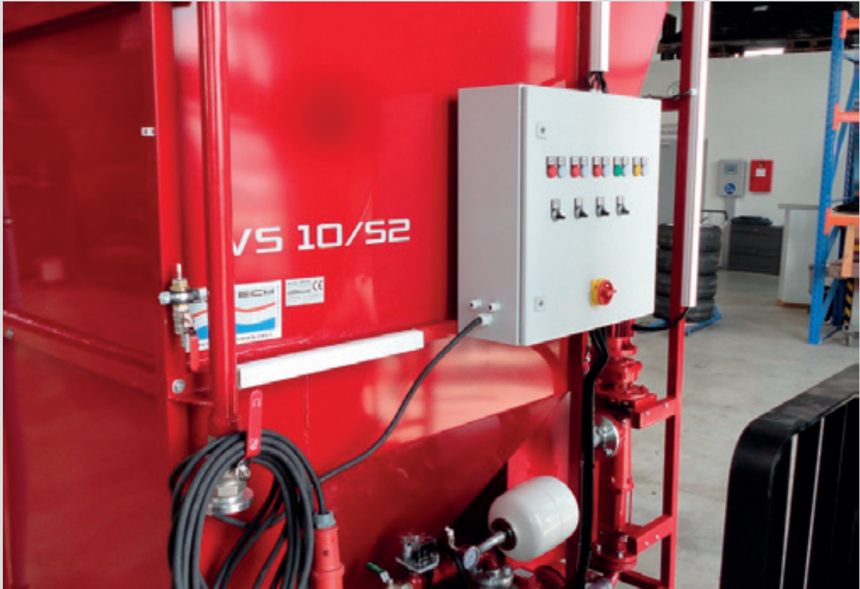
Schaltanlage VS 10/S2
