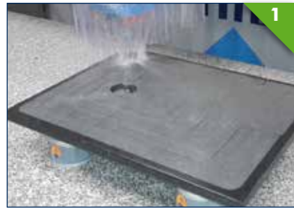
1 Milling on a shower tray Décaissage sur bac à douche Fräsen einer Duschwanne Fresado en un plato de ducha
