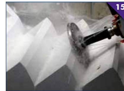
15 Machining & polishing of stairs Usinage & polissage d'escalier Treppen schleifen & polieren Mecanización y pulido de escalera
