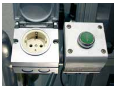
Stromversorgung im Arbeitskorb
