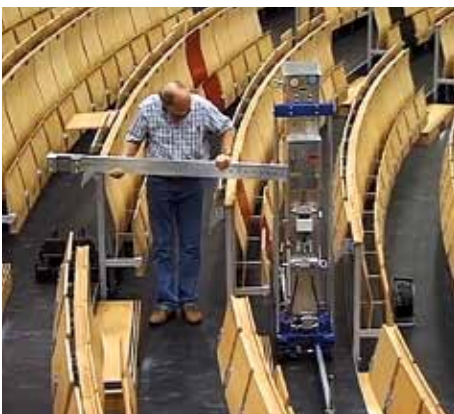
Installation der horizontalen Ausleger
