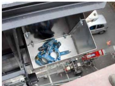
Pritsche ist mit Ablagefächern für Kleinteile ausgestattet
